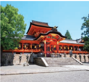
◀正殿屋顶为扁柏树皮葺，与屋檐相接处还架设了织田信长进献的“黄金檐沟”
