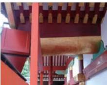
◀正殿屋顶为扁柏树皮葺，与屋檐相接处还架设了织田信长进献的“黄金檐沟”
