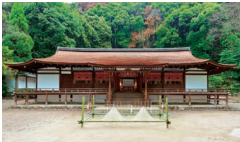
▲前殿的“切妻”造式屋顶采用精美的“缃破风”手法加以装饰，是一大看点
