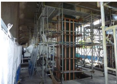
耐震補強工事（イメージ）
