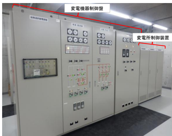
変電機器制御盤と変電所制御装置（外観図）
