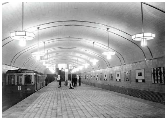
完成時の心斎橋駅の様子
