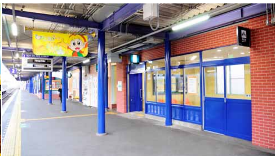
美装化工事が完了する「枚方公園駅」
