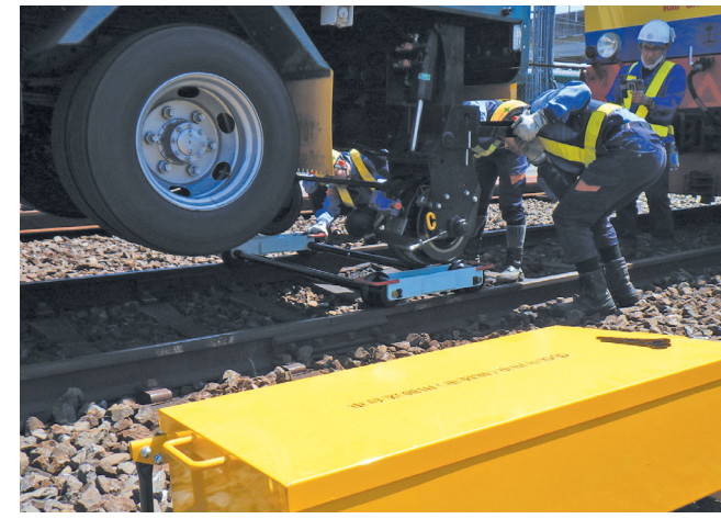
▲ 搬送台車を用いた架線自動車緊急脱出訓練
