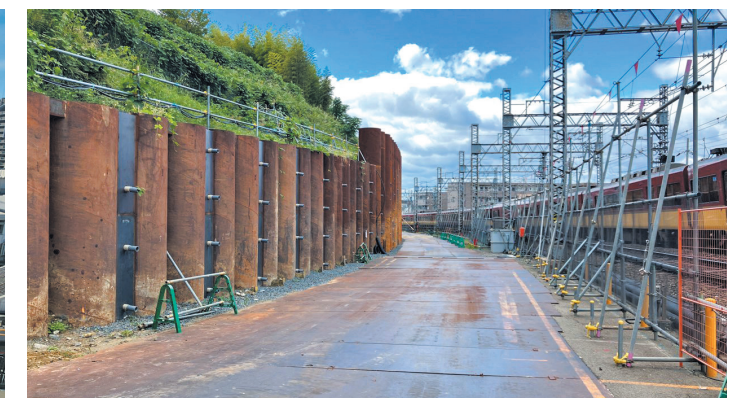
▲ 終点方取付部付近における斜面切取工事
