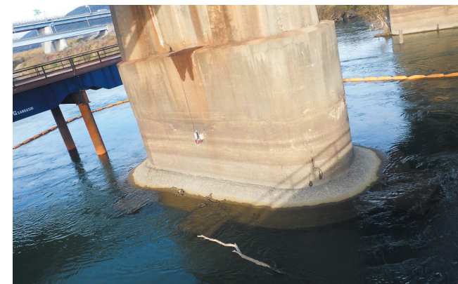
▲補強工事前の橋脚
