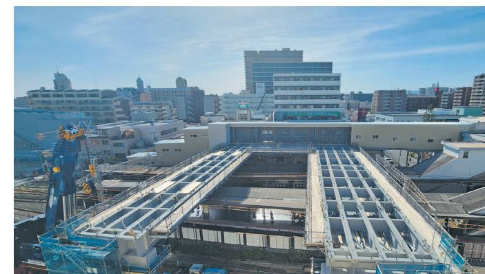
▲ 香里園駅部における仮駅工事
