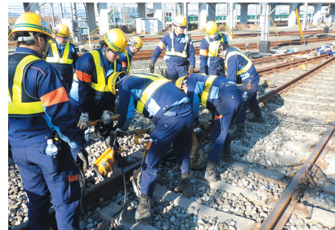
▲ 軌道の保守作業実務研修
