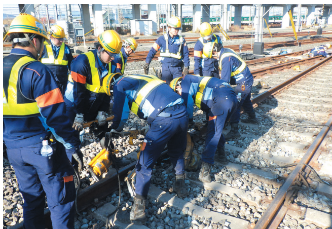
▲ 軌道の保守作業実務研修
