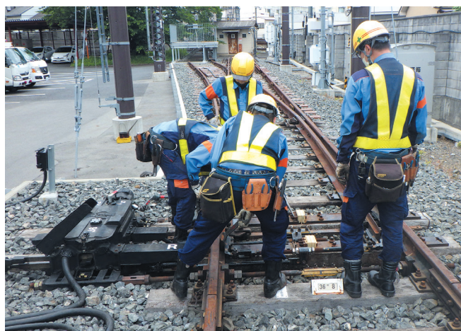
▲ 電気転てつ機据付用品の取付・調整訓練
