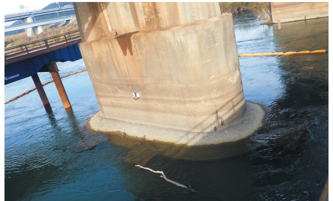
▲補強工事前の橋脚
