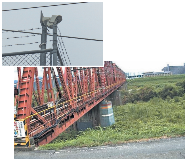
▲河川監視カメラ(上)とその映像(下)
