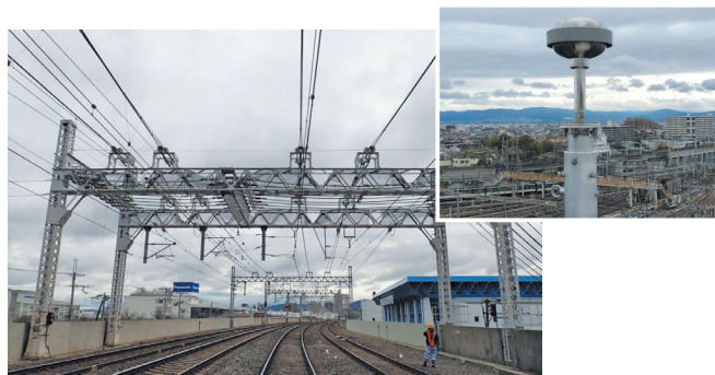
▲守口変電所付近
