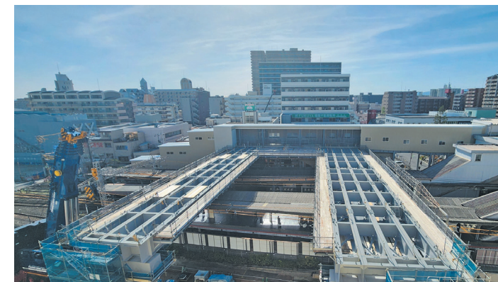
▲香里園駅部における仮駅工事
