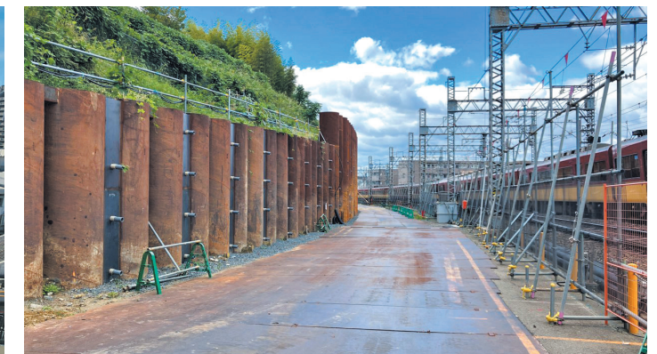
▲終点方取付部付近における斜面切取工事
