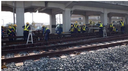
軌道の保守作業実務研修
