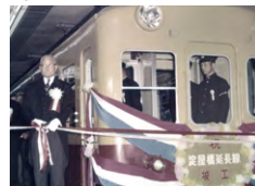
淀屋橋地下延長線竣工 (天満橋駅-淀屋橋駅間)
