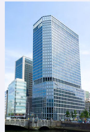
建物外観(北西方より)
