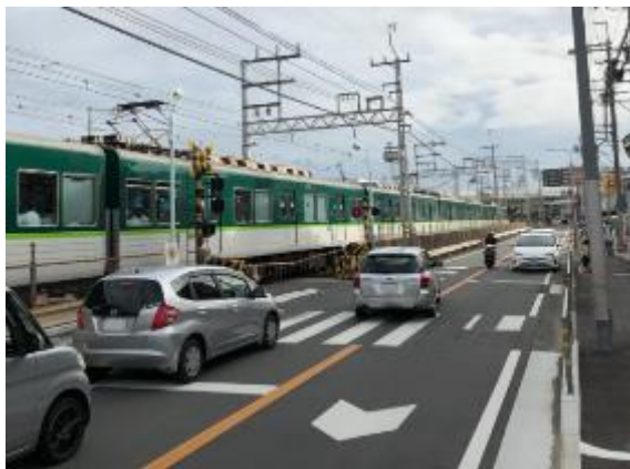
現況 （光善寺駅～枚方公園駅間）
