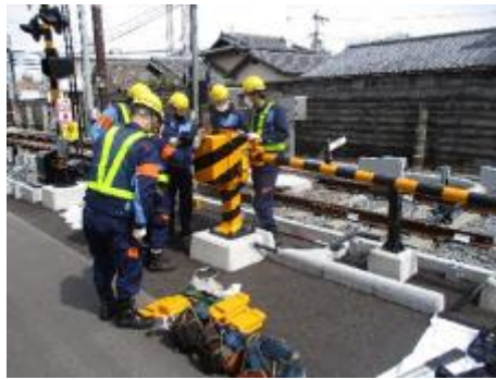
踏切保安装置の復旧訓練
