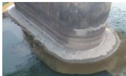
補強工事前の橋脚
