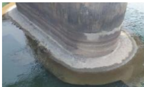
補強工事前の橋脚
