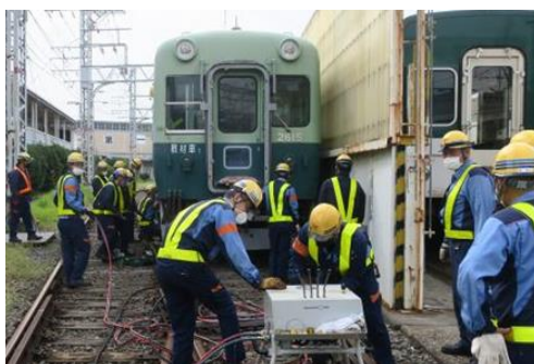
脱線復旧訓練
