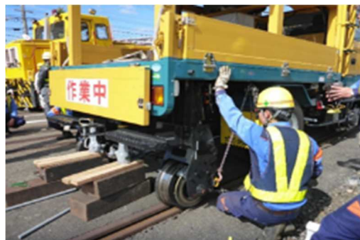
架線車の脱線復旧訓練
