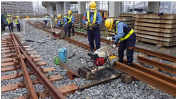
軌道の保守作業実務研修
