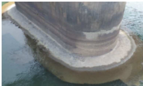
補強工事前の橋脚
