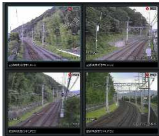
急傾斜法面監視カメラの映像
