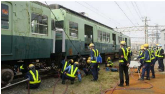
脱線復旧訓練
