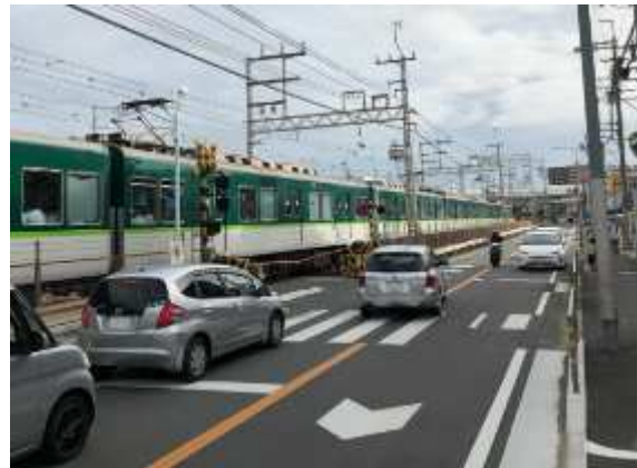
現況 (光善寺駅～枚方公園駅間)
