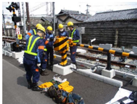
踏切保安装置の復旧訓練
