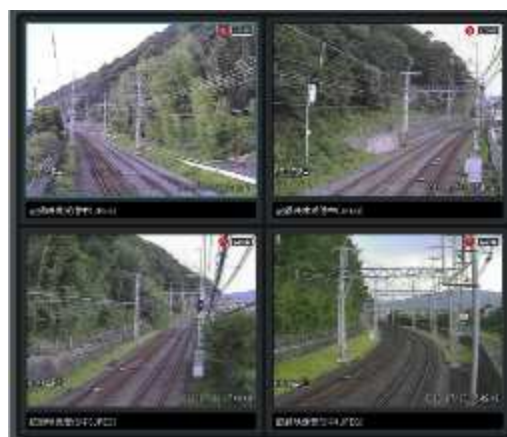
急傾斜法面監視カメラの映像
