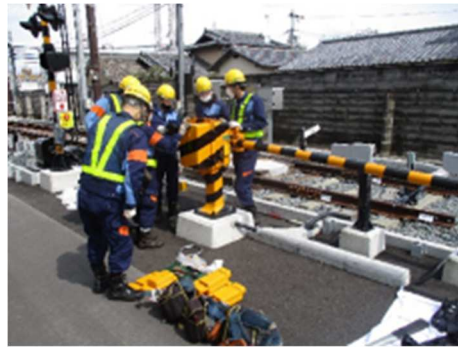
踏切保安装置の復旧訓練
