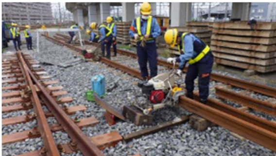
軌道の保守作業実務研修
