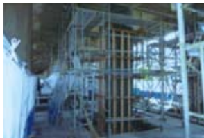
高架橋耐震補強
