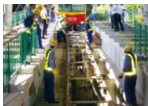
鋼索線の点検・整備
