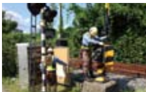
信号機の復旧訓練
