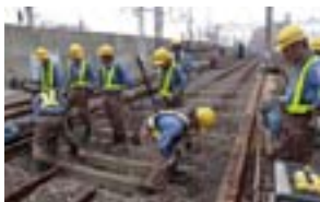
軌道の保守作業実務訓練
