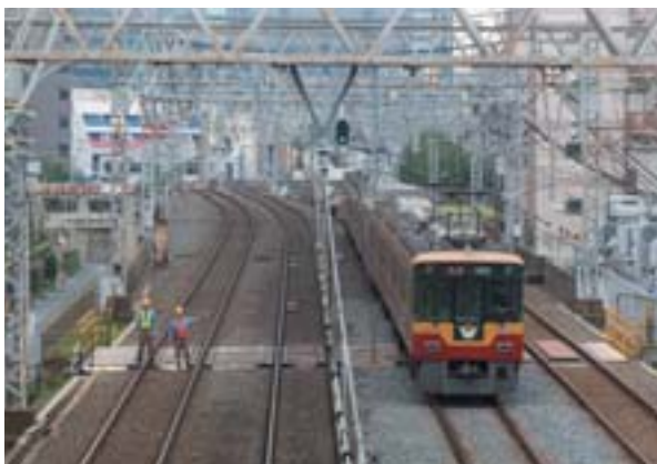
▲ 線路巡視作業
