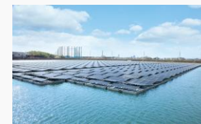
ため池を活用した太陽光発電 (大阪府枚方市)
