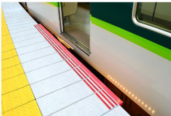
各種安全対策の事例（左：ホーム先端部くし状ゴムと足下灯、右：踏切支障報知装置）
