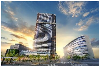
ジオタワー大阪十三（2026年1月竣工予定）
