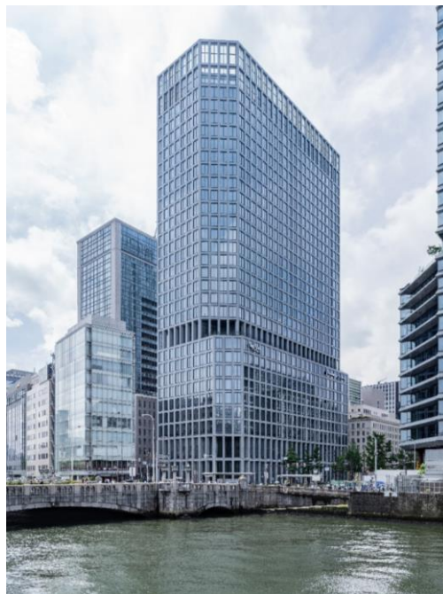
建物外観（北西方より）
