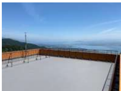
ケーブル延暦寺駅屋上「山のデッキ」
