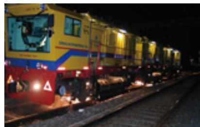
▲レールの頭頂面の削正作業
