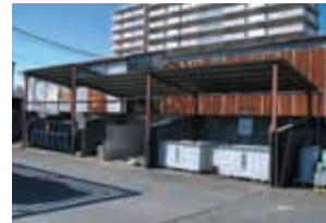
油が地面に流出しないよう設置した廃棄場の屋根
