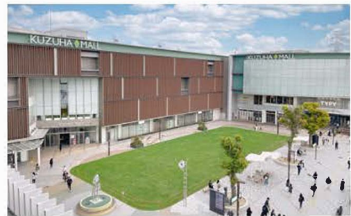
■天然芝を敷き詰めたリニューアル後の駅前広場
