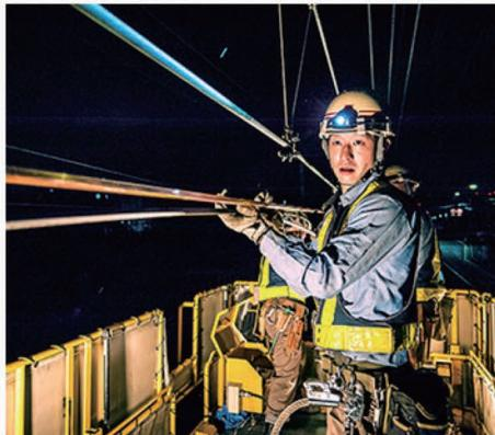
新線をすべて張り終えたら、今度は仮止めをしておいた旧線をドラムに巻き取る作業を行い完全に撤去します。電車線の巻き取りは相当な力を要する作業です。また、巻き終わりはしっかりと固定しないとゆるみが生じ、巻いている線が暴れて切断面でケガをすることもあるので十分な注意が必要です。3名がかりでドラムに巻き取り、無事に終了しました。300m区間の古い電車線が新しい電車線に入れ替えられ、既存線とつなぐと作業完了です。すべての工具が元通りそろっているかチェックして工事は終了。今回はカーブや踏切の多い区間ではなかったため、工事は順調に進み、予定より少し早めの午前3時50分に終了しました。
