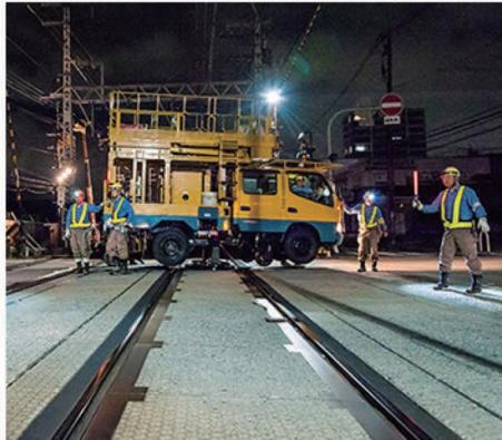
今夜は架線自動車と呼ばれる高所作業車が3台出動して張り替え工事を実施。架線自動車とは、高所作業用のパケットがついた、車道も軌道も走行できる軌陸両用車です。そのため現場に到着したらタイヤから軌道を走る鉄輪に変換し、レールの上にスタンバイしてスタートします。ちなみに架線自動車にも各鉄道会社に独自色があり、京阪電車の場合は“安全色”的イエローと“車両カラー”的グリーンを効かしたツートンカラー仕様。午前1時20分過ぎ、精鋭の技術者11名が架線自動車3台に分散乗車していよいよ作業が始まりました。
