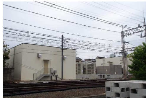
深草変電所（外観）
