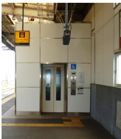
エレベーター
