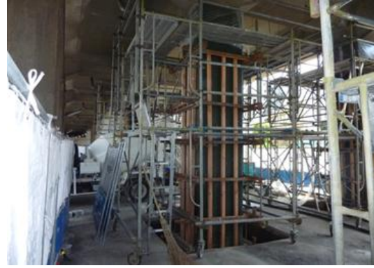
耐震補強工事（イメージ）
