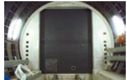
▲なにわ橋駅側(ローラー式ゲート) 非常時:扉が閉まっている状態
