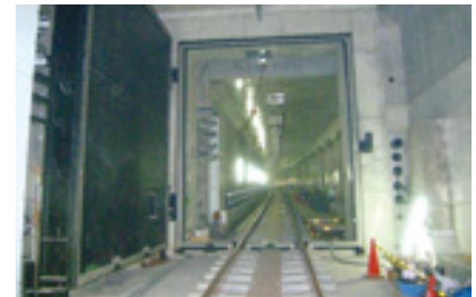
▲天満橋駅側(スイング式ゲート) 通常時:扉が開いている状態
