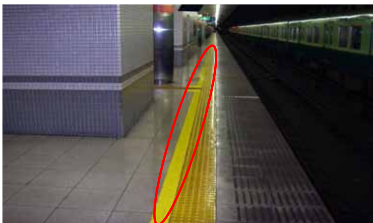
ホーム点字ブロック内方線
