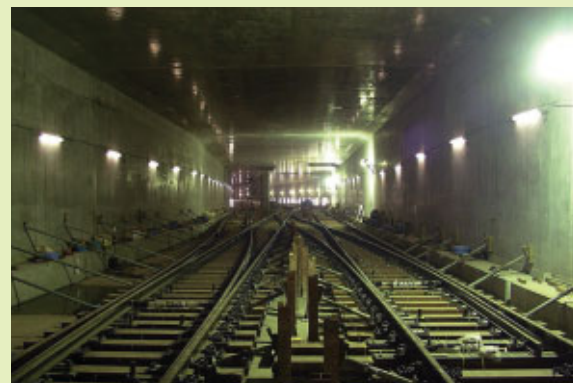
▲中之島駅付近軌道敷設状況
