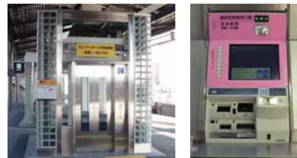
▲萱島駅にエレベーターを新設
