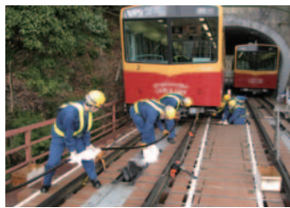
鋼索の点検・整備
