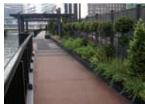
景観に配慮した仮設遊歩道
