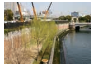
仮護岸をレンガで装飾
