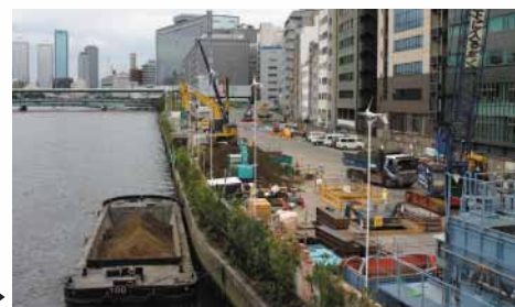
工事残土を舟運を用いて搬出する様子 ▶
